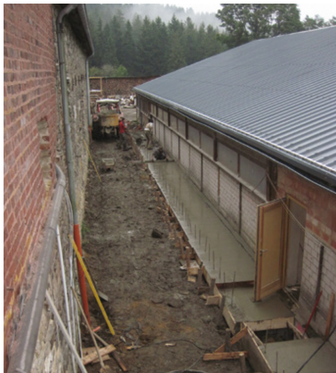
Der Zugang zur Notkapelle und späterer zur Kirche ist im Entstehen
