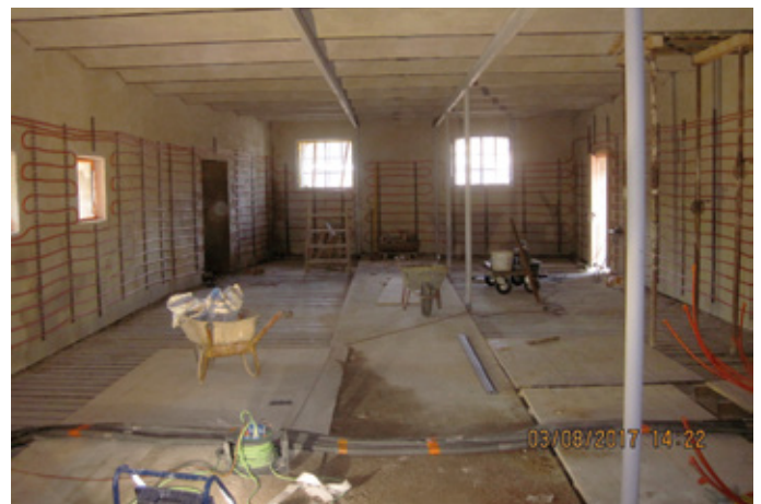
Die zukünftige Notkapelle im Ausbau
