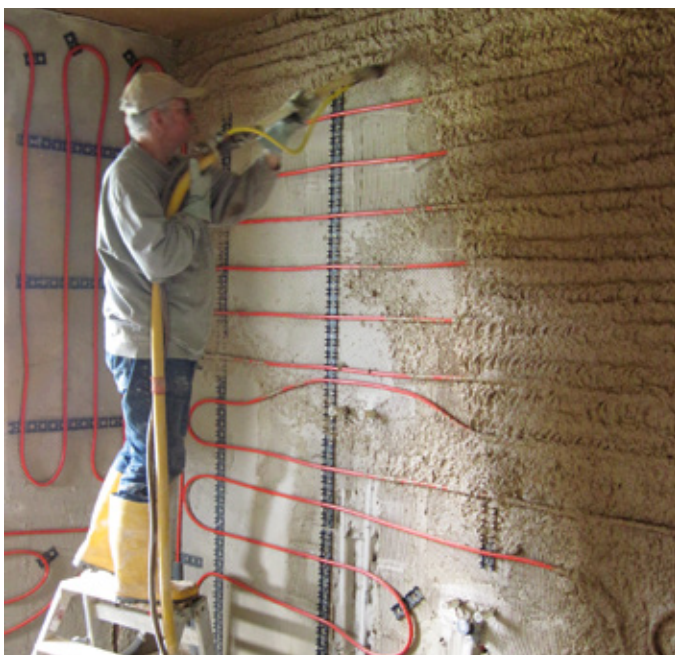
Das Melkerhaus wird verputzt
