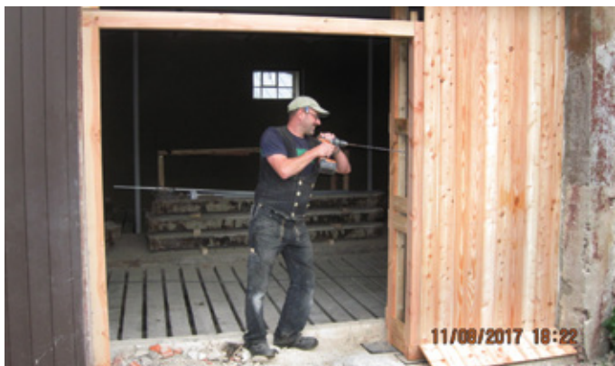
Ein vorhandenes Tor im Bereich der Notkapelle wird geschlossen
