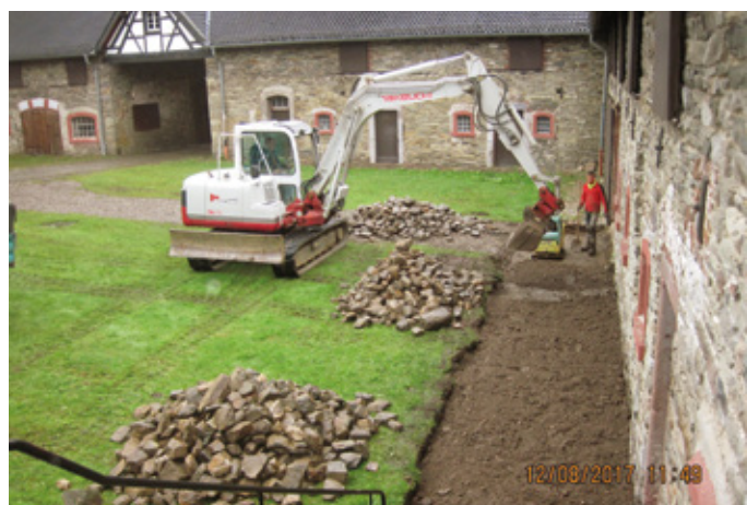
Entlang der Notkapelle wird ein Pflaster gebaut
