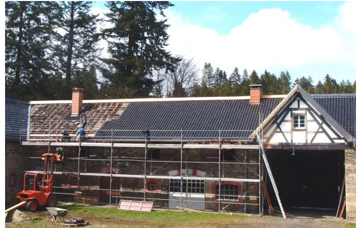
Dacharbeiten am Nordwestflügel
