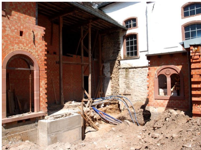
Arbeiten am Südflügel: links unten der neue Lüftungsschacht – im Hintergrund die Klosterkirche – links und rechts Teile des Kreuzganges, der an dieser Stelle jetzt geschlossen werden soll.
