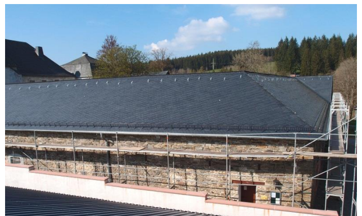
Die neu verschieferten Außenseiten des Ost- und Nordostflügeldaches
