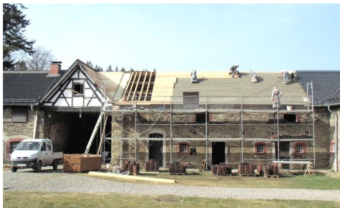
Renovierung des Nordostflügeldaches
