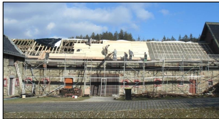
Dachrenovierung am Ostflügel
