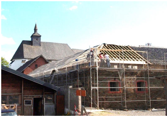
Ansicht des Ost- und Nordflügeldaches Von rechts nach links sieht man die alten Dachpfannen, die Sparren, die neue Einschalung und die Dachpappe
