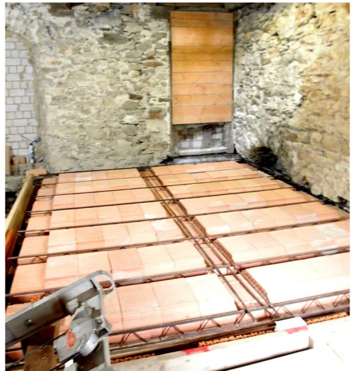
Die Ziegeleinhängedecke bereit zum Ausgießen mit Beton
