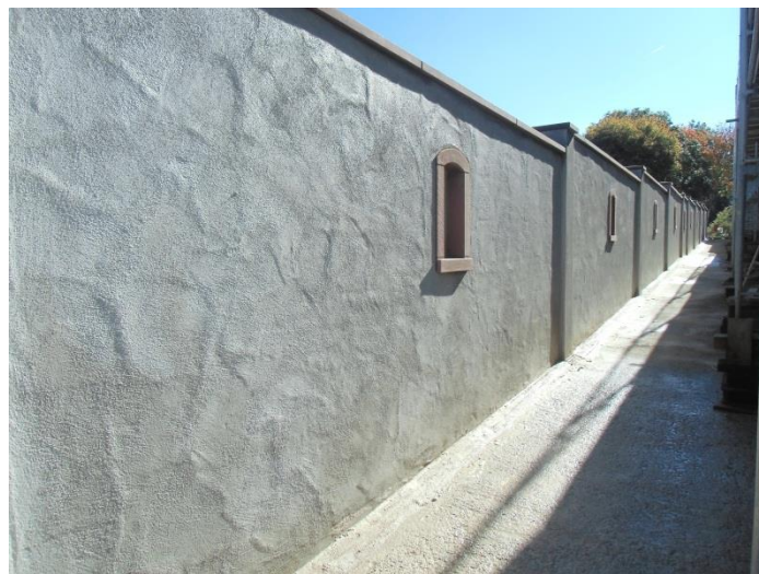
Die neu verputzte Trennmauer an der Besucherzugangsrampe zur Klosterkirche
