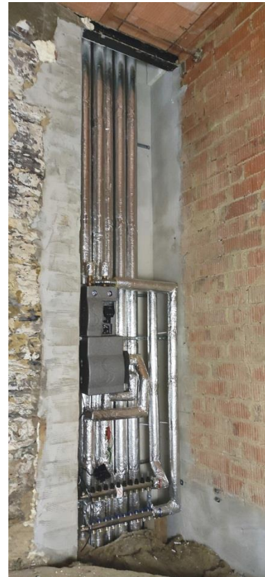
Die neu verlegten Heizungs- und Wassertransportleitungen im Südflügel
