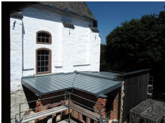
Die neue Sakristei und ein Teil des neuen Kreuzganges mit neuer Zinkbedachung
